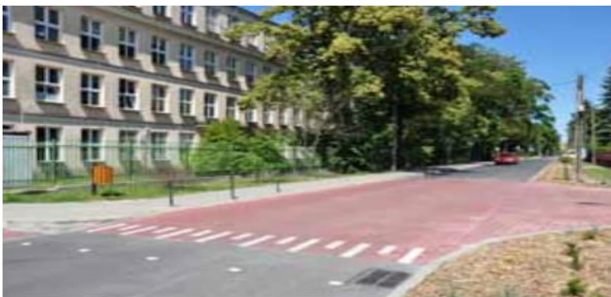
Fotografia 2 Skrzyżowanie wyniesione na ul. Żwirowej przy szkole w Brwinowie
