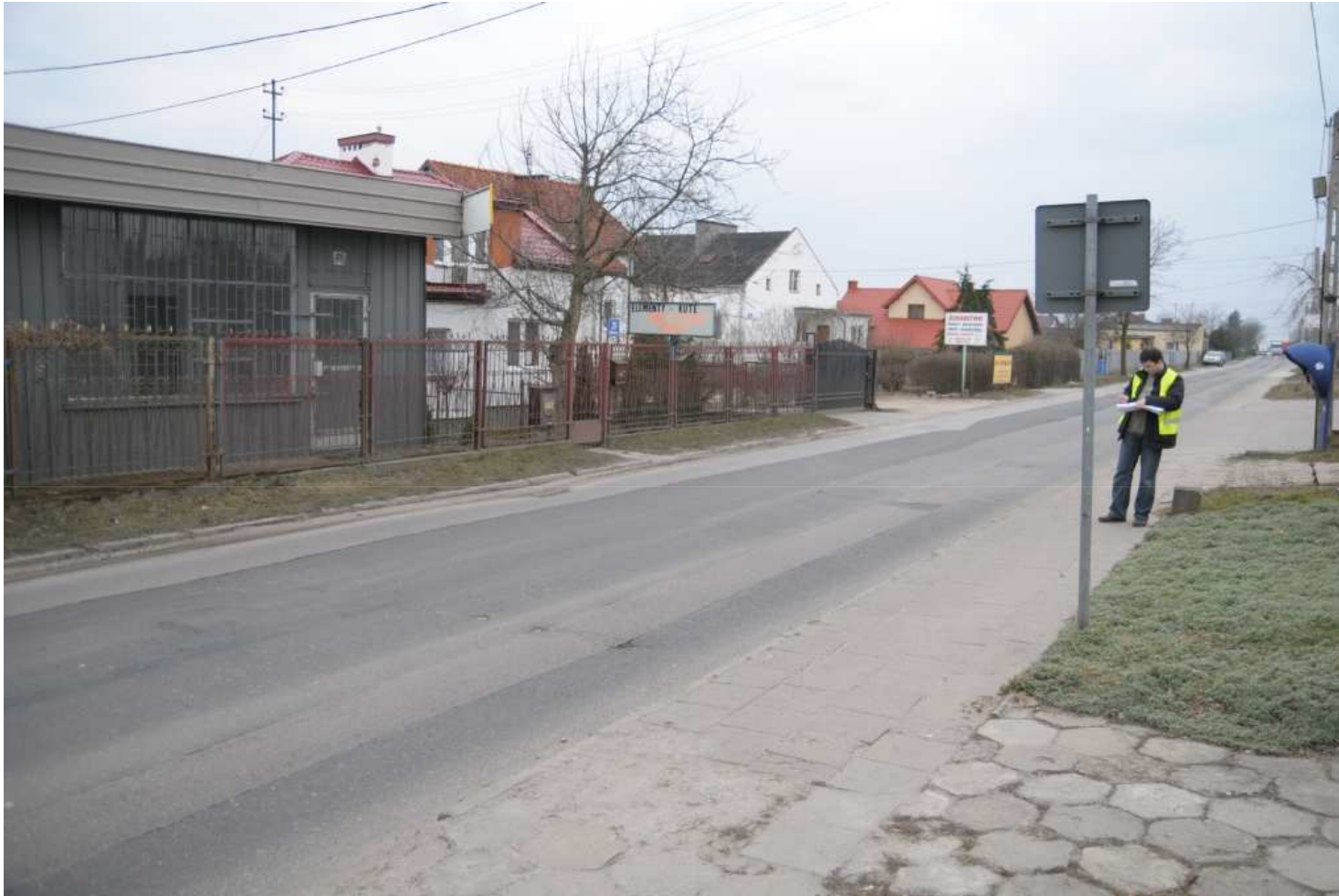
ul. Główna w Parzniewie - przed przebudową
