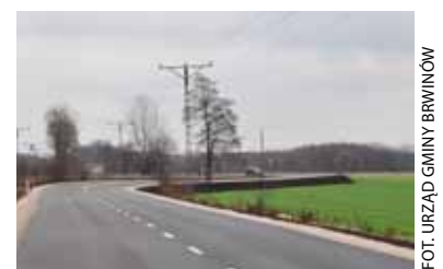
Na zdjęciu: Gładki asfalt na trasie Brwinów-Parzniew. Teraz na bezpieczną drogę czekają jeszcze roweryści i piesi.
