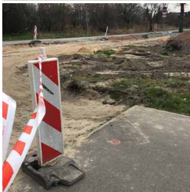
Na zdjęciu u góry: stan prac na początku kwietnia. Poniżej: skrzyżowanie, gdzie droga rowerowa z Brwinowa rozwidli się w dwie strony – Fałęcina i Milanówka.
