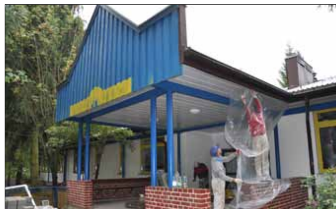
Na zdjęciach powyżej: remontowana sala lekcyjna w LO w Brwinowie i prace w czasie wakacji w szkole w Otrębusach.
